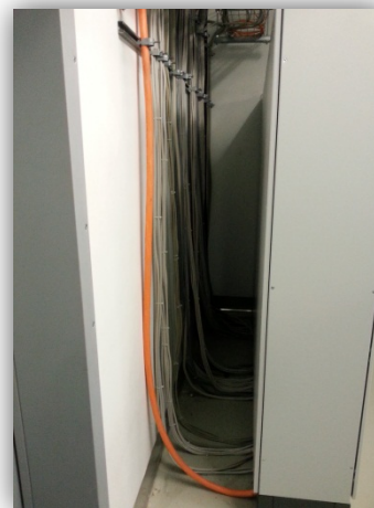
Bild 13: Schaltschrank Wandaufstellung mit 50cm Abstand
