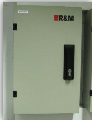
Bild 33: Spleißbox, geschlossen
