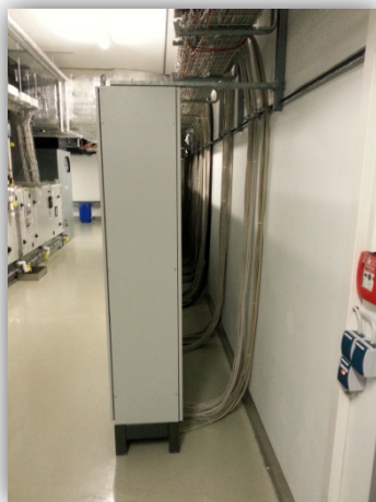
Bild 12: Schaltschrank Wandaufstellung mit 50cm Abstand
