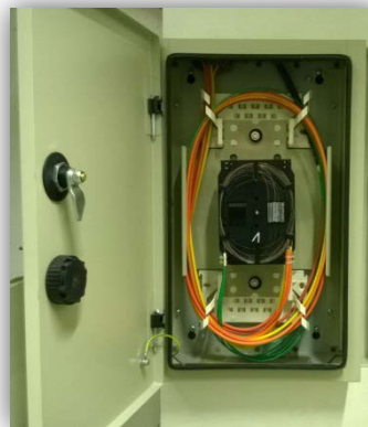
Bild 34: Spleißbox, geöffnet voll bestückt
