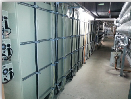
Bild 11: Beispiel Schaltschrank frei im Raum mit Rückseite Kabelleiter
