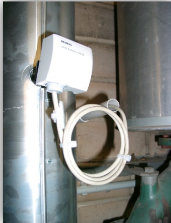
Bild 15: Feldgerät mit Leitungsring
