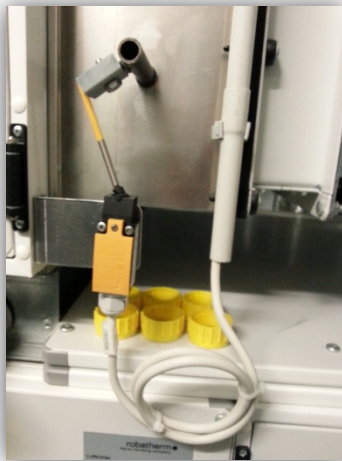
Bild 17: Endschalter Luftklappe
